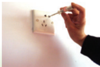
图 9-1-8 用验电笔检验插座的相线
