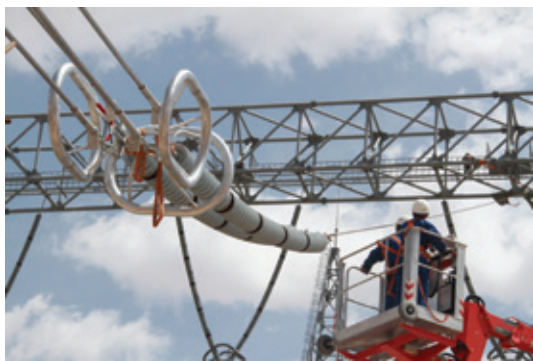
图3 特高压线路铺设
