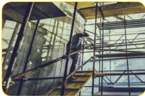
脚手架上的斜面
