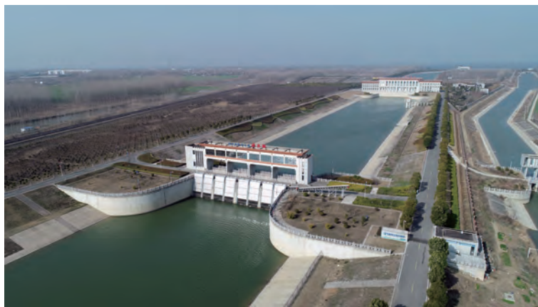
图 4-5 南水北调工程现场
