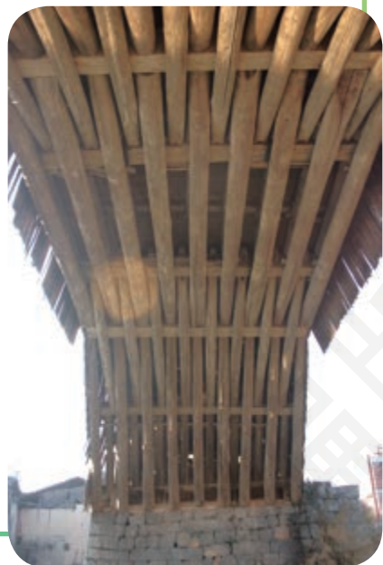
桥梁中的榫卯结构
