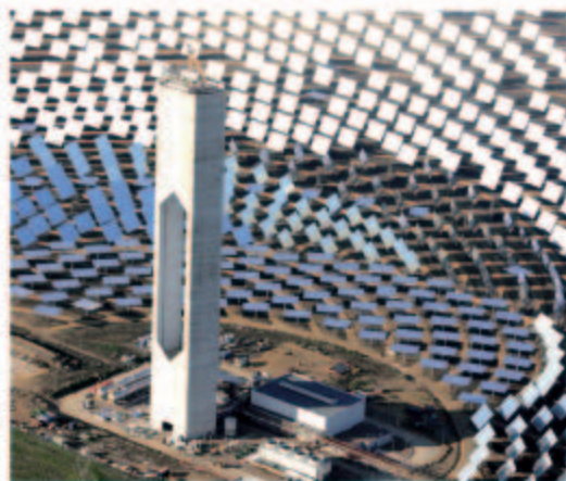
图4.3-5 塔式太阳能电站
