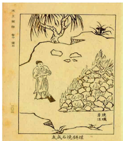
图7-20 明代宋应星《天工开物》中的烧石灰图
