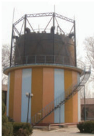
图 16-4 沼气发酵池
