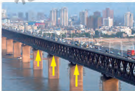
桥墩被压后，产生向上的支持力
