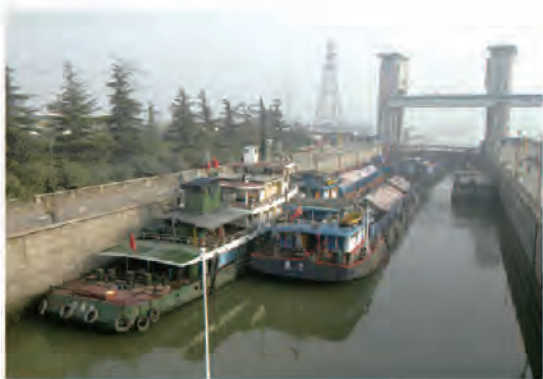
图 4-23 葛洲坝 2 号船闸
