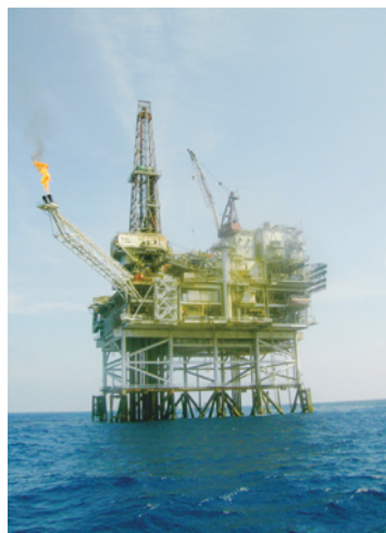
渤海湾海上石油井架
