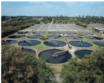
集中处理工业废水
