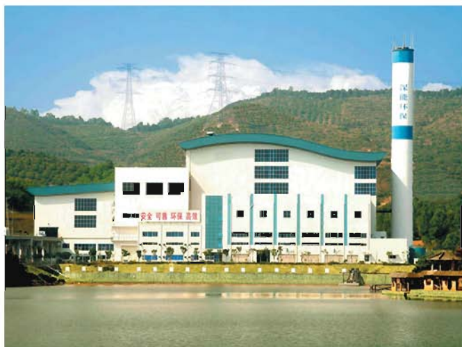
图9-20 垃圾沼气发电厂
