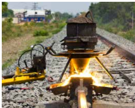
图 3-1-7 利用三氧化二铁粉末与铝粉的反应焊接钢轨
