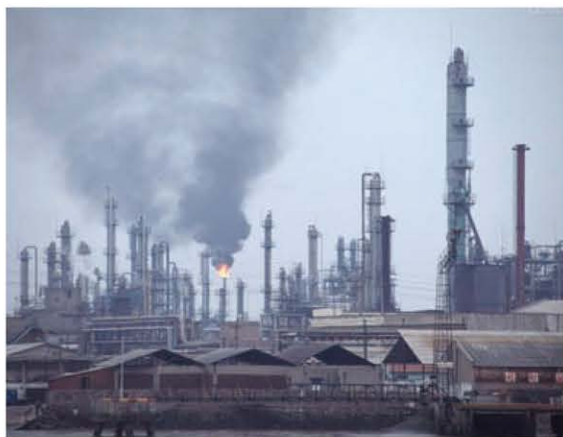
有害气体排放
