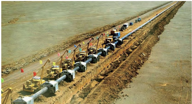
图 3-15 西气东输工程穿越我国西部戈壁
