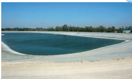
图3-73 沙漠里的水库
