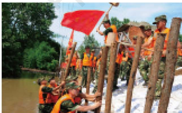
图 3-2-8 参加抗洪救灾的解放军战士在打桩加固堤坝
