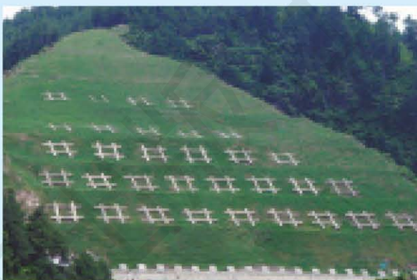
图 3-2-5 贵州省鹅山冲滑坡治理
