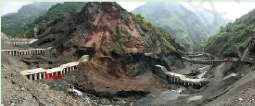
图 3-2-1 都坝河上游物源区建造的桩林坝
