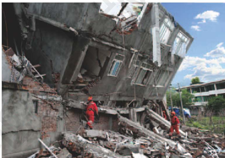
图 2-1-10 2014 年四川雅安地震造成的破坏
