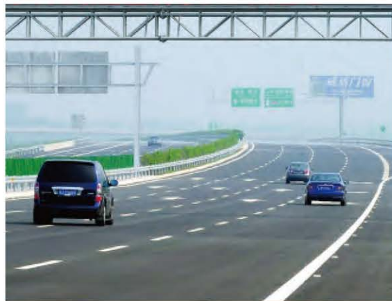
京津高速公路
