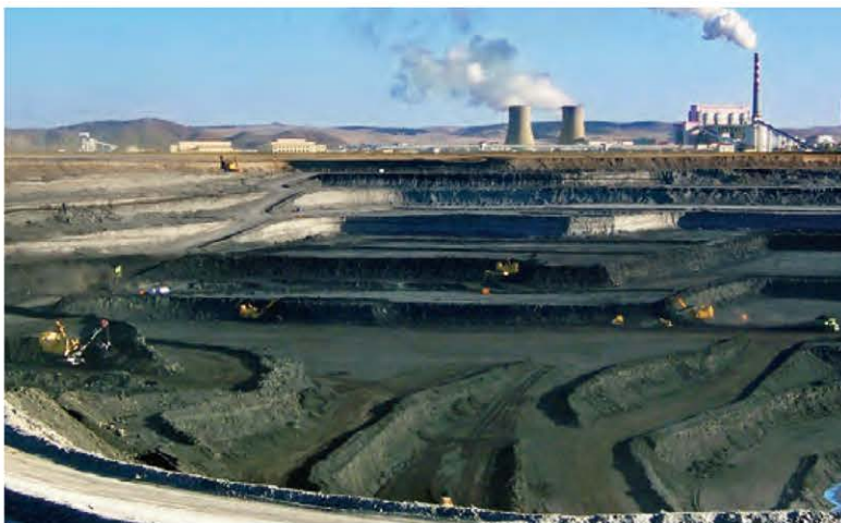
内蒙古霍林河露天煤矿
