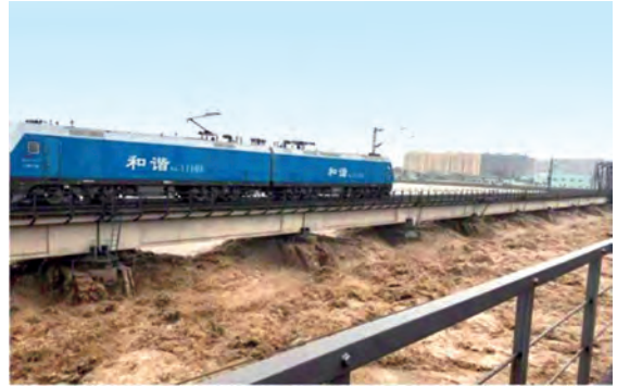
图 2-36 重载列车“镇桥”抗击洪水
