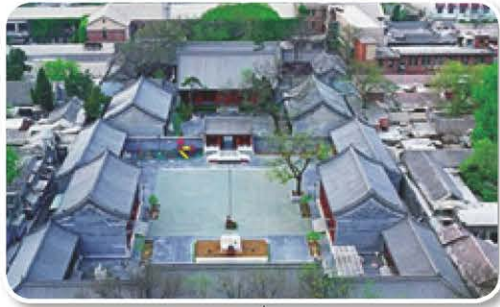
北京传统四合院 北京冬冷夏热，春早多风沙。因此，住宅设计注重保温防寒避风沙，外围砌砖墙，整个院落被房屋与墙垣包围。
