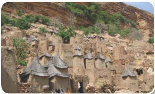
多贡人的村落 非洲马里的多贡人，在恶劣的自然条件下生活，用泥黏合石块砌成墙，用野草做屋顶。房子多建在陡坡上，以防外侵。
