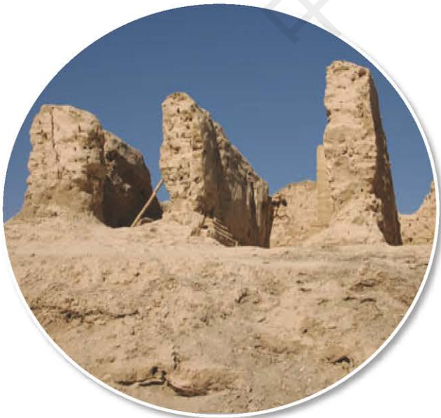
新疆楼兰古城遗址 楼兰古城残存的墙垣散布于人迹罕至的荒漠上。因受当地自然环境逐渐恶化的影响，这些墙垣也面临着消失的危险。
