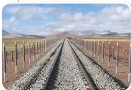
Ⓑ 冻土上的青藏铁路 多年冻土段超过青藏铁路全长的一半，低温“热棒”技术的运用，可以解决冻土层夏季融沉、冬季冻胀的问题。
