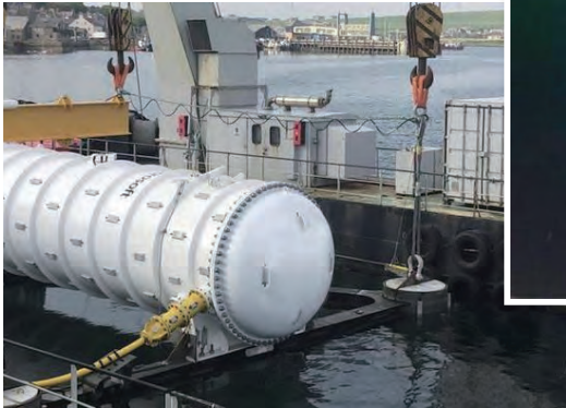
图 4-7 准备沉入海中的数据中心
