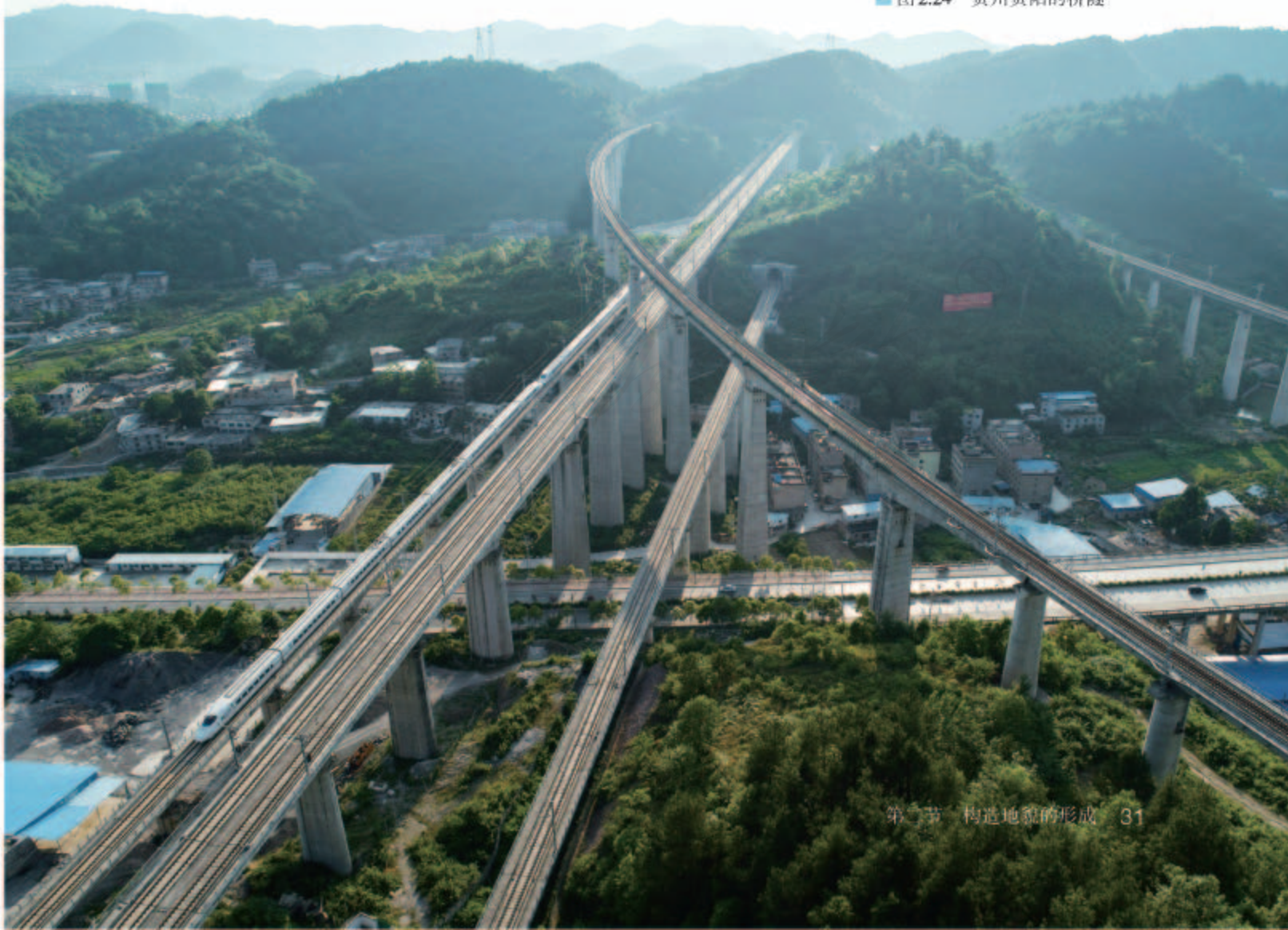
图2.24 贵州贵阳的桥隧
