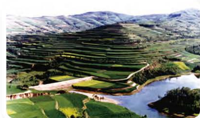
治理水土流失的工程措施 在沟谷兴修小型水库、打坝淤地，在坡面修建梯田等。
