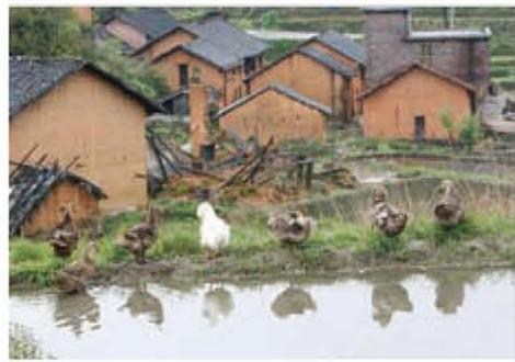
东部地区雨水较多，两面坡屋顶利于迅速排除雨水。
