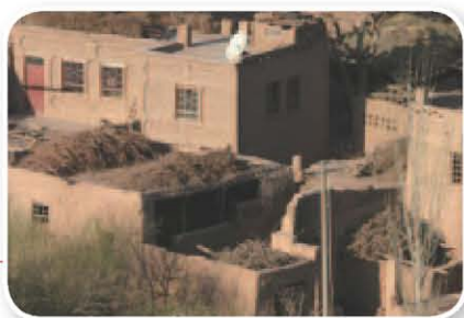
① 西北地区的平顶屋 少有雨雪的地区，平顶屋可节省建材和晾晒谷物。
