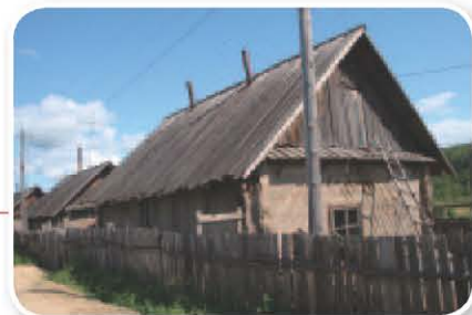
② 东北地区的尖顶屋 尖顶屋有利于积雪滑落，防止压损房屋。
