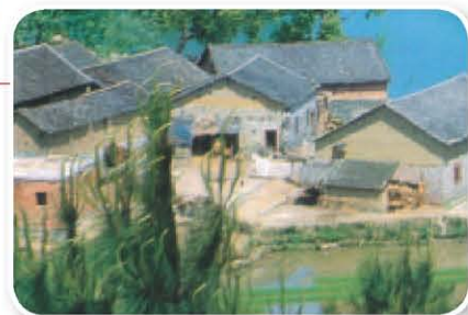
④ 东南地区的两面坡顶屋 角度较大的屋顶有利于快速排除雨水。
