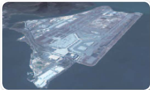
香港国际机场鸟瞰图 香港国际机场位于大屿山以北，由填海造陆修建而成。
