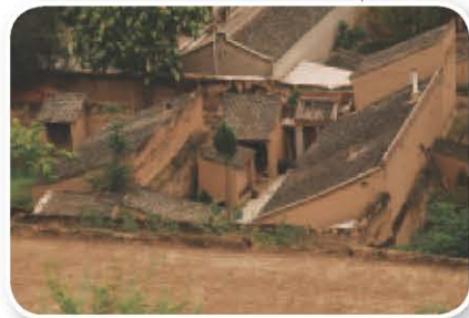
③ 黄土高原地区的单面斜坡顶屋 黄土高原干旱少雨，房屋的屋顶只有一侧，朝向自家院内，可收集珍贵的雨水。
