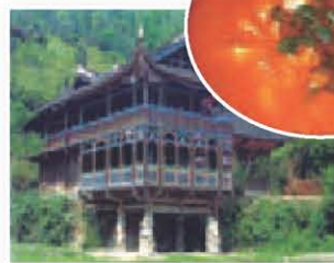
苗族高架吊脚楼民居
