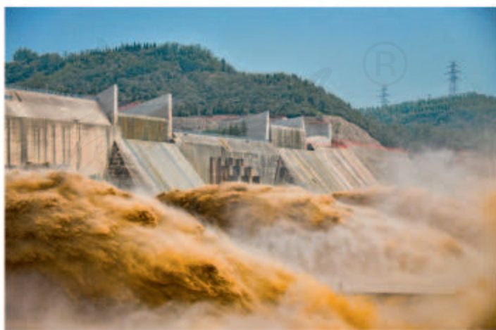
小浪底工程从2009年竣工到2015年，累计将下游河道中9.66亿吨淤沙送入大海，“地上河”没有再长高，黄河下游基本保持冲淤平衡。
