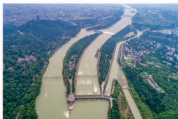
图2.2 都江堰水利工程
