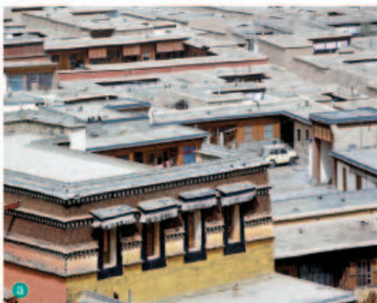
① 甘肃夏河县的土墙平顶屋
