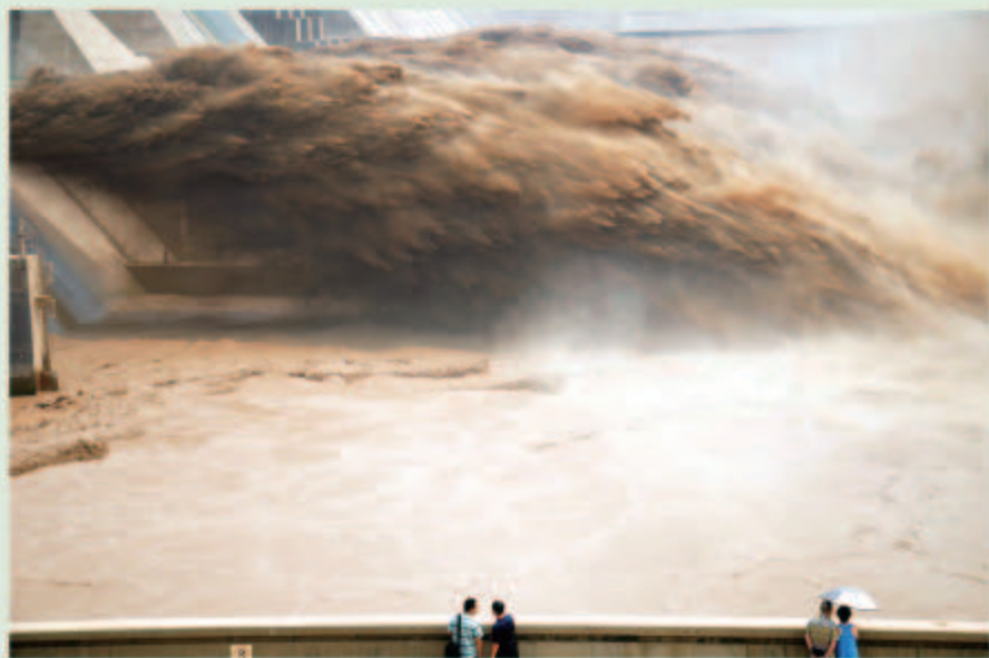
图2.44 黄河小浪底水利枢纽调水调沙的壮观场面
