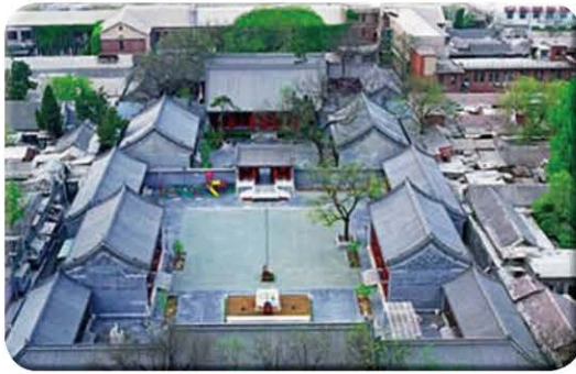
北京传统四合院 北京冬冷夏热，春早多风沙。因此，住宅设计注重保温防寒避风沙，外围砌砖墙，整个院落被房屋与墙垣包围。
