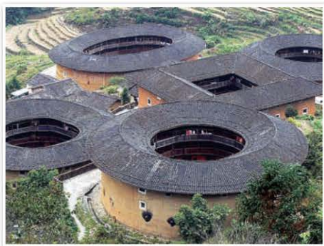
中国的福建土楼 福建土楼是世界上独一无二的山区大型夯土民居建筑。土楼依山就势，布局合理，具有节约、坚固、防御性强等特点。
