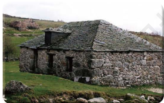
石板屋 在阿尔卑斯山区的村落，常能见到这种用石板搭建的既能抵御大风、又耐火的房屋。
