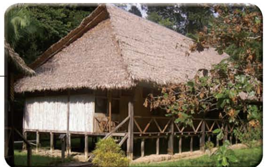
高架屋 在气温高、雨水多的亚马孙地区常能见到这种通风良好、又避免潮湿的高架式房屋。
