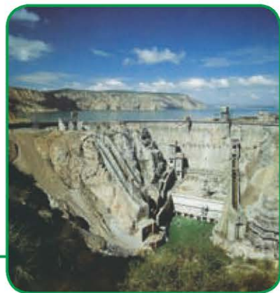
龙羊峡水电站
