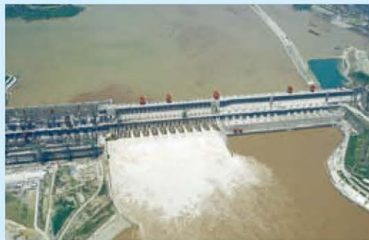
三峡大坝泄洪
