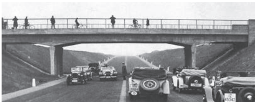
▲ 通行之初的科隆—波恩高速公路
