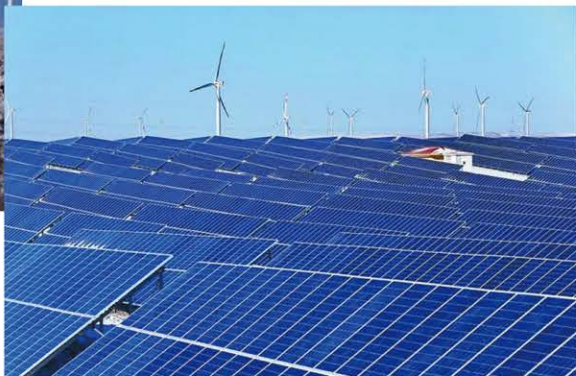
张家口的风电场和光伏电站
