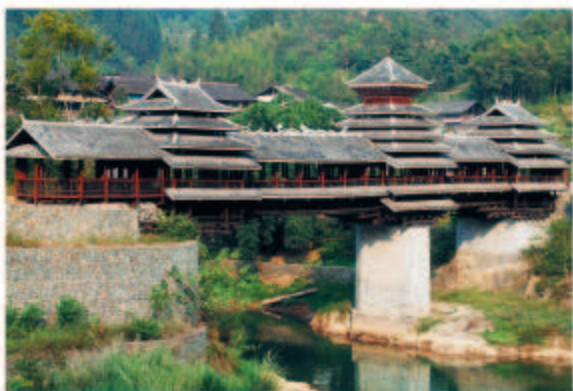
贵州地坪风雨桥
