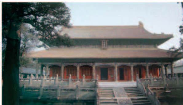
▲山东曲阜孔庙大成殿（建筑）
