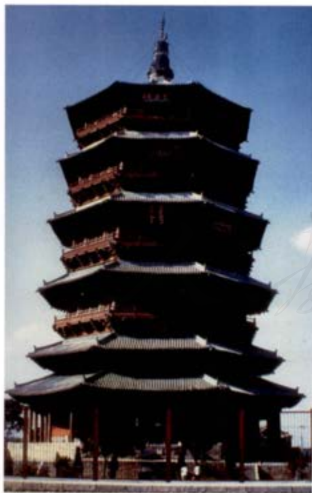
◆ 应县木塔（建筑）[辽代] 山西应县
