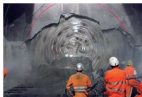
用大型掘进机开凿隧道
