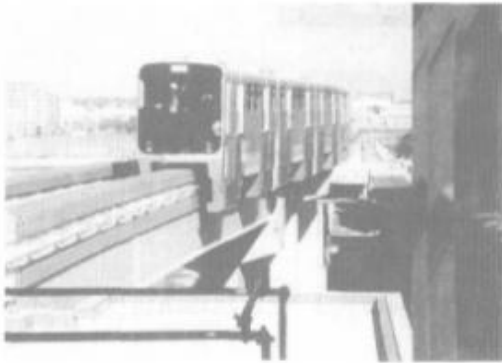
图 2-1-1 跨座式独轨铁路
