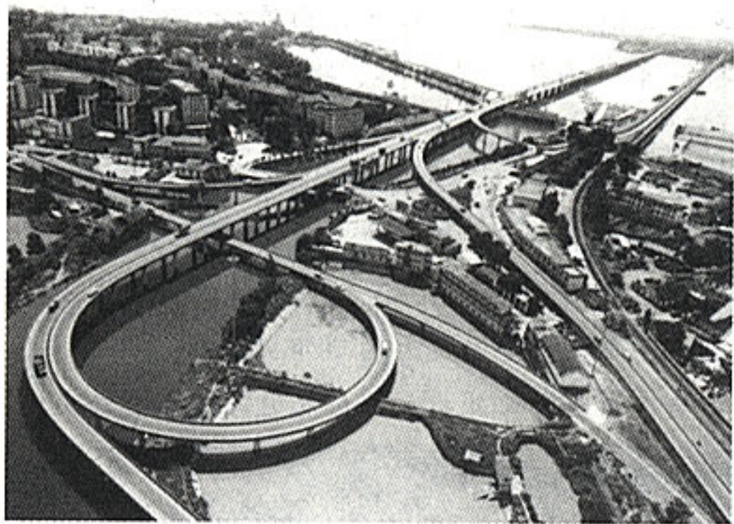
厦门跨海公路大桥
