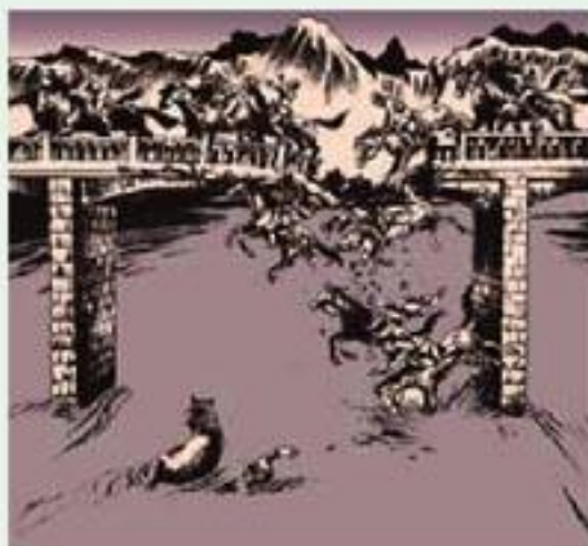
图 11.5-5 桥梁的共振。1831年,一队骑兵通过曼彻斯特附近的一座便桥时,由于马蹄节奏整齐,桥梁发生共振而断裂(漫画)。
