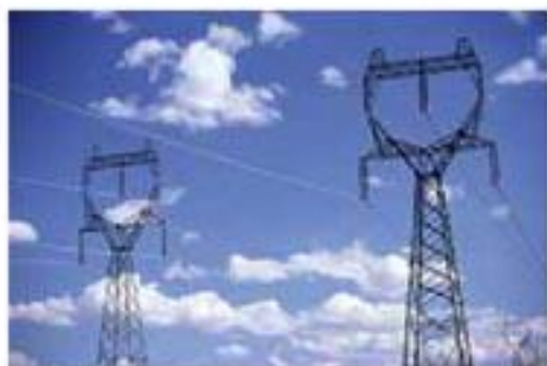
图1.7-7 铁塔上面的两条导线接地，把输电线屏蔽起来。
