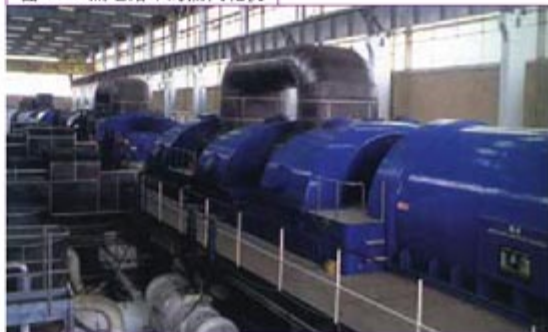
图 4.3-3 热电站中的蒸汽轮机
