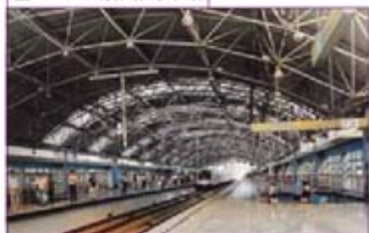
图 2.3-7 网架结构车站
