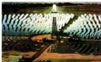
图4.3-4 太阳能热电站的塔式集光阵
