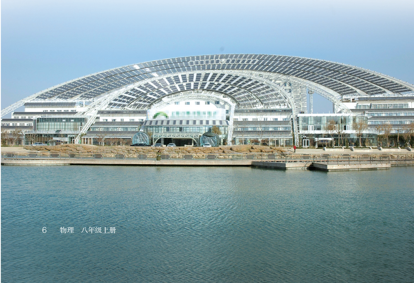
图11 绿色节能的太阳能建筑——现代社会对能源的需求越来越多，而煤炭和石油等不可再生能源越用越少。太阳能可以说取之不尽，而且是清洁能源。太阳能建筑综合运用了太阳能热水供应、采暖、制冷、光伏发电等技术，实现了太阳能与建筑的完美结合。
