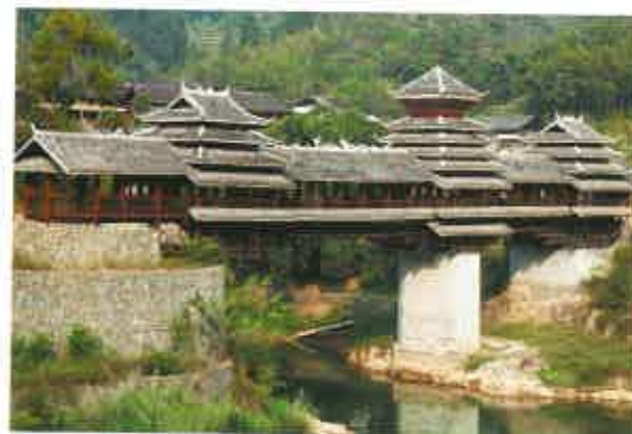
贵州地坪风雨桥
